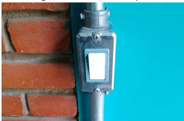
Figura 91: Troca do interruptor
