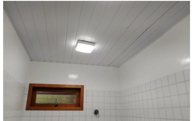
Figura 80: Pintura das paredes PCD
