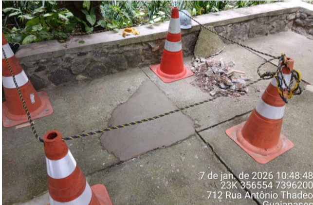
Figura 75: Reparo do piso quebrado
