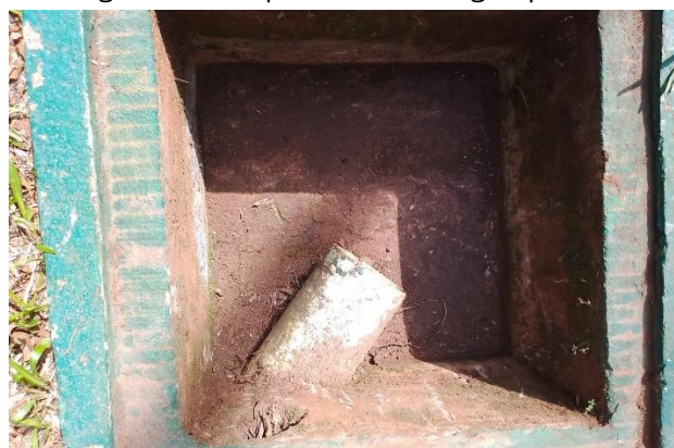
Figura 96: Limpeza caixa de água pluvial
