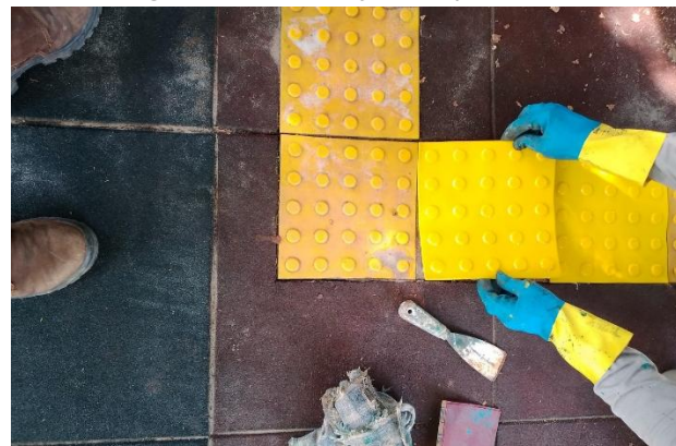
Figura 98: Colocação do piso tátil
