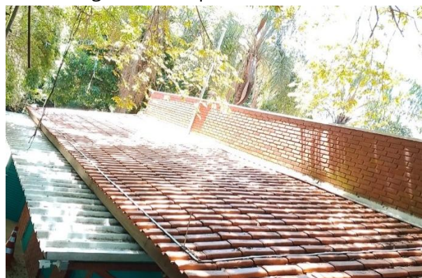
Figura 92: Limpeza dos telhados
