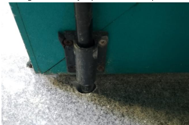
Figura 84: Furação para o trinco da porta
