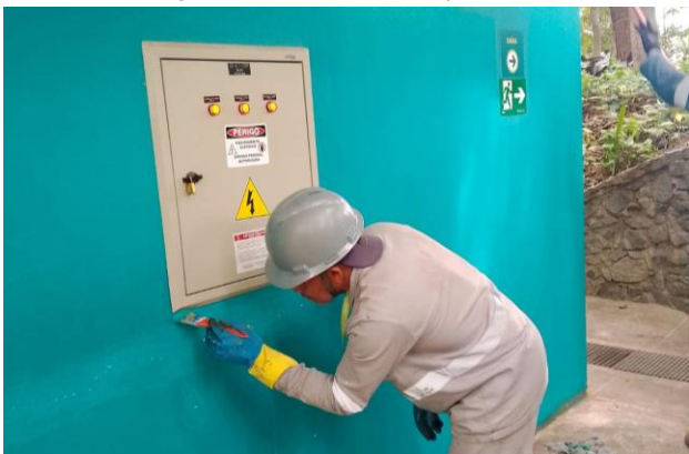
Figura 97: Pintura da parede
