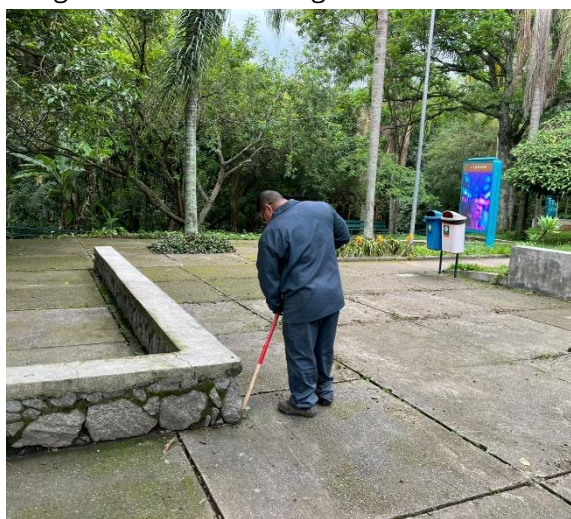
Figura 15: Retirada de grama do concreto
