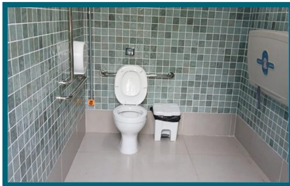
Figura 62: Limpeza dos sanitários acessíveis
