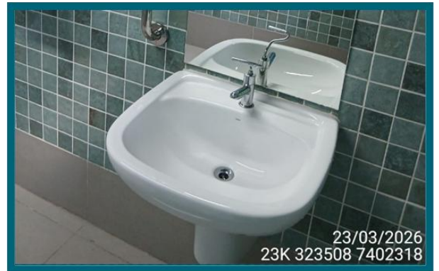
Figura 51: Limpeza dos sanitários acessíveis
