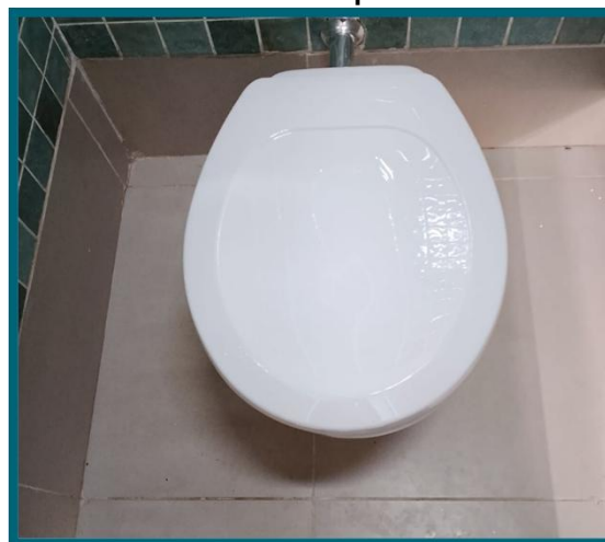
Figura 102: Vaso sanitário: após a instalação da tampa
