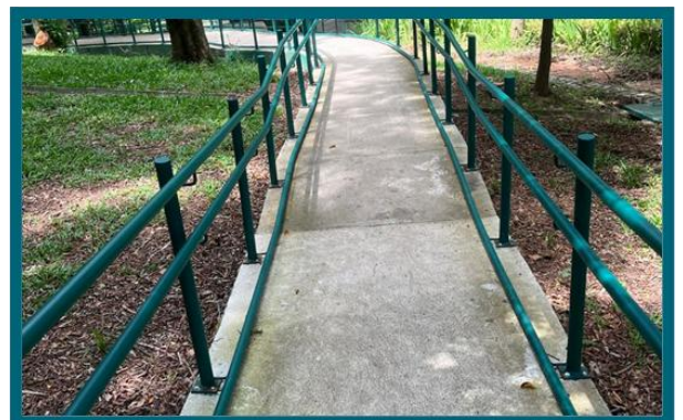
Figura 80: Limpeza das rampas
