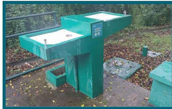
Figura 90: Limpeza do bebedouro - depois
