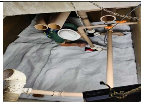
Figura 222: Manutenção preventiva: Lago das carpas Restaurante Selvagem
