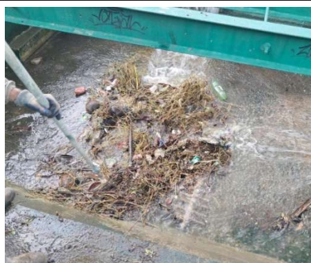
Figura 230: Manutenção preventiva: Limpeza no Vertedouro
