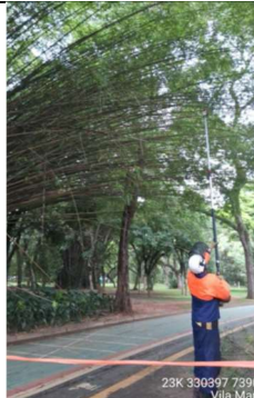
Figura 112: Remoção de bambu quebrado
