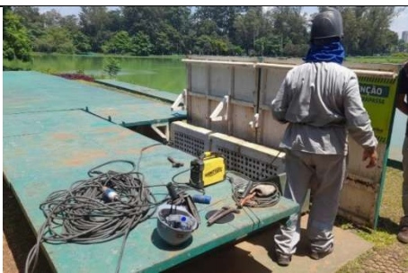
Figura 219: Manutenção na porta do Bunker da Fonte Multimídia
