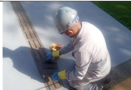
Figura 210: Manutenção no piso tátil do Auditório
