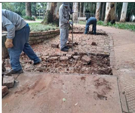
Figura 227: Manutenção de pisos e acessos
