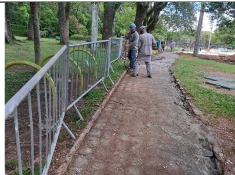
Figura 212: Implementação de rota acessível na Pista de Skate
