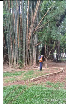
Figura 113: Remoção de bambu quebrado
