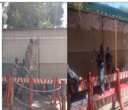
Figura 228: Instalação e pintura do telhado na parte externa área operacional
