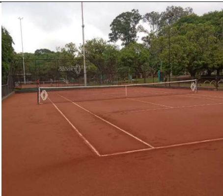
Figura 217: Manutenção preventiva quadra de saibro
