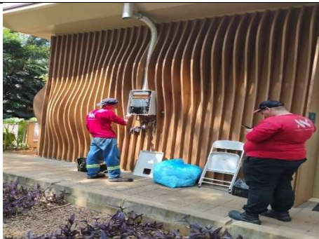
Figura 211: Manutenção preventiva dos aquecedores
