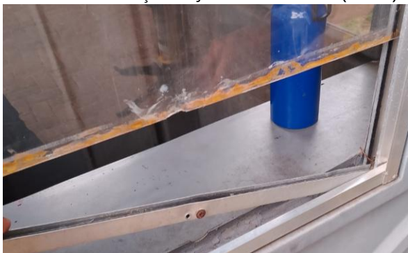
FIGURA 166 FIXAÇÃO DE JANELA DA GUARITA (ANTES)
