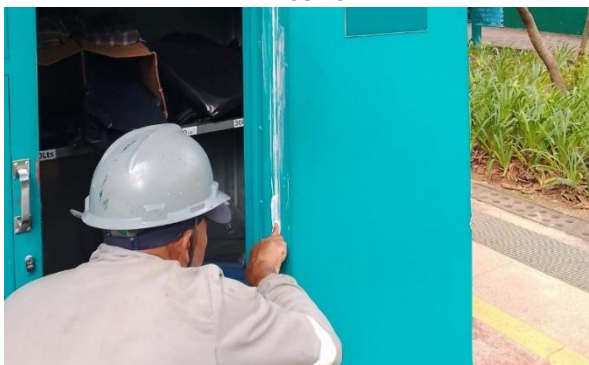
FIGURA 162 REPARO DE RACHADURA NA PORTA DO DEPÓSITO
