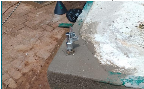
FIGURA 149 REPARO DE BEBEDOURO (DEPOIS)
