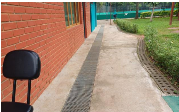
FIGURA 131 LIMPEZA NO ENTORNO DO PRÉDIO PRINCIPAL
