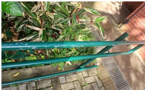
FIGURA 125 LIMPEZA DOS GUARDA-CORPOS
