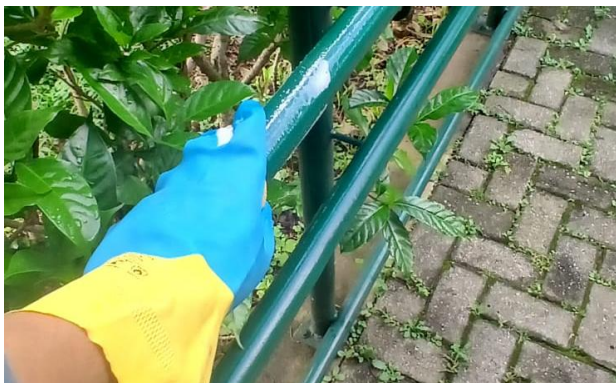
FIGURA 124 LIMPEZA DOS GUARDA-CORPOS
