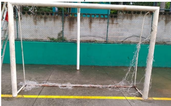
FIGURA 160 SUBSTITUIÇÃO DAS REDES DOS GOLS
