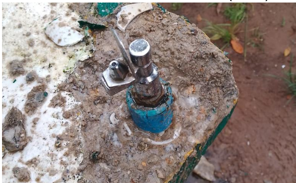
FIGURA 148 REPARO DE BEBEDOURO (ANTES)
