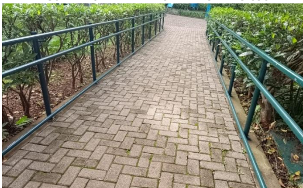
FIGURA 126 LIMPEZA DAS RAMPAS DE ACESSO
