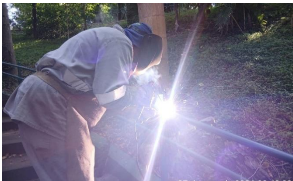
FIGURA 172 SOLDA E PINTURA DE GUARDA-CORPO
