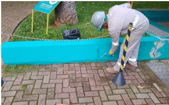
FIGURA 146 REPARO DE RACHADURAS E PINTURA DE MURETA
