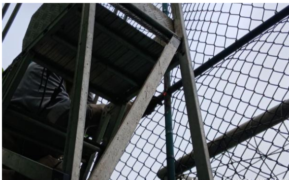
FIGURA 170 SOLDA DO ALAMBRADO DO CAMPO
