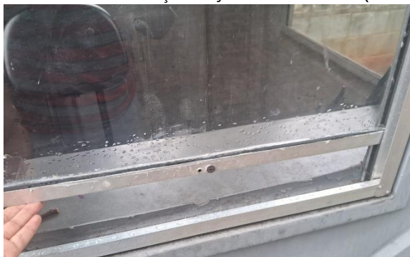
FIGURA 167 FIXAÇÃO DE JANELA DA GUARITA (DEPOIS)
