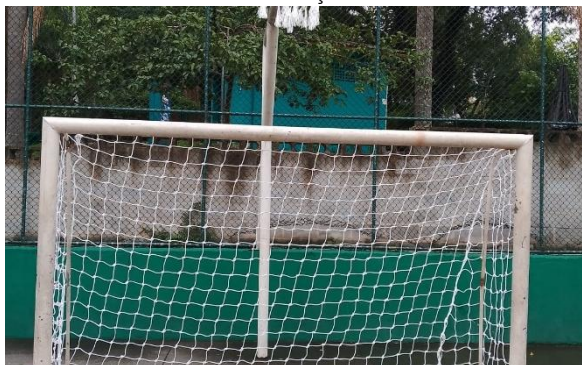
FIGURA 161 SUBSTITUIÇÃO DAS REDES DOS GOLS
