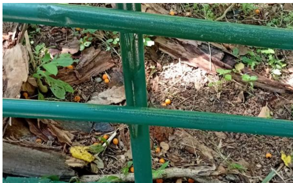
FIGURA 173 SOLDA E PINTURA DE GUARDA-CORPO
