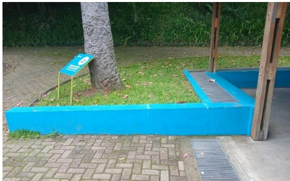
FIGURA 147 REPARO DE RACHADURAS E PINTURA DE MURETA
