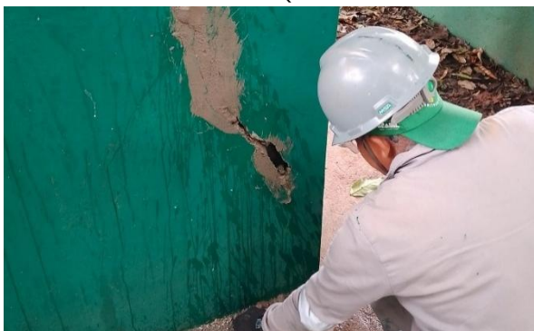
FIGURA 142 REPARO DE RACHADURA NA CHURRASQUEIRA
