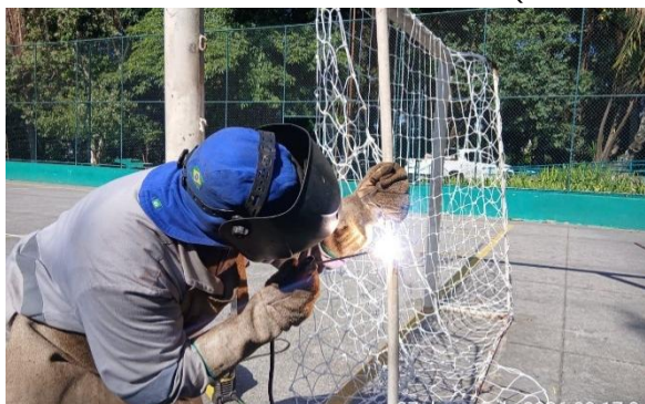
FIGURA 175 SOLDA DA TRAVE DA QUADRA
