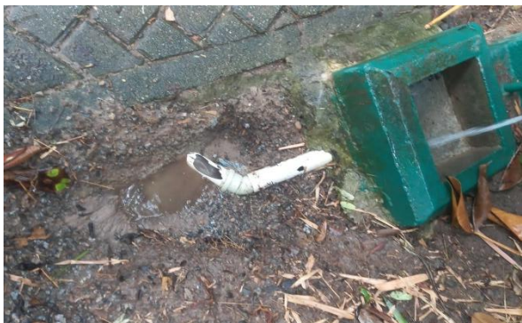
FIGURA 164 DESENTUPIMENTO DO CANO DO BEBEDOURO
