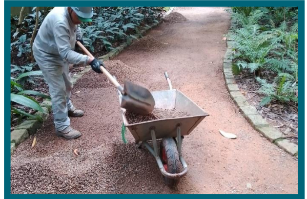
Figura 93 Preenchimento de pedrisco em trilha
