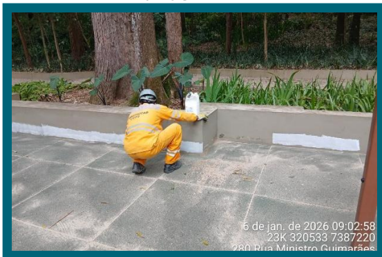
Figura 108 Lixamento e selagem das muretas do playground
