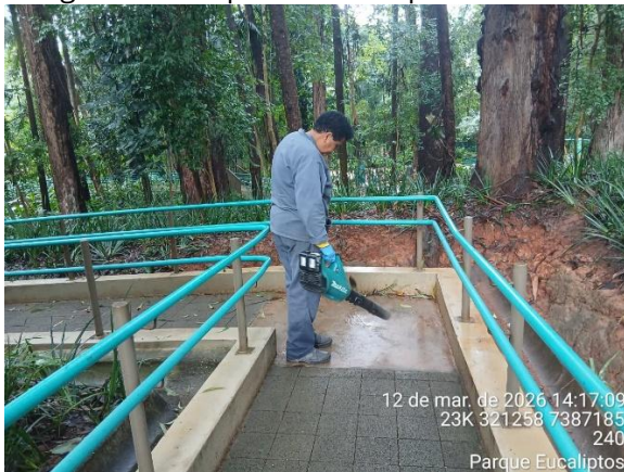
Figura 64: Limpeza das rampas acessíveis
