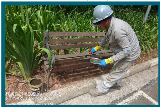
Figura 102 Lixamento e envernizamento dos bancos da entrada principal
