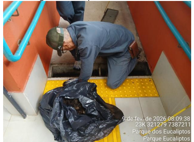
Figura 22: Limpeza das canaletas
