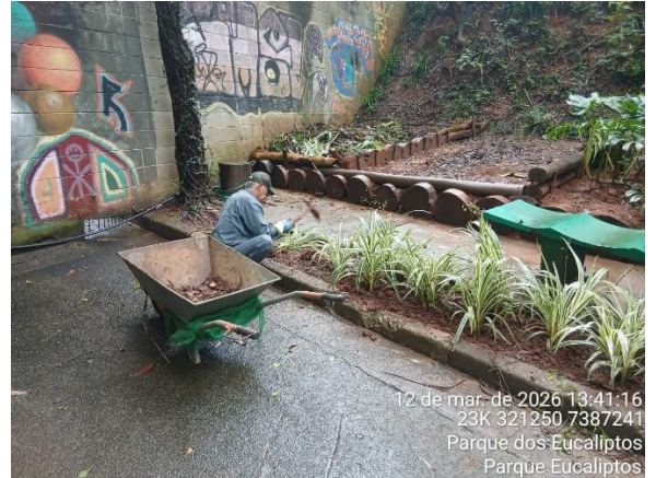
Figura 20: Manutenção de canteiros
