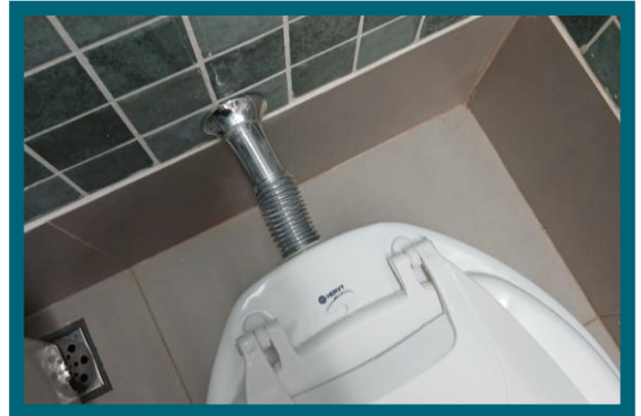
Figura 99 Conserto de vazamento do sifão do banheiro
