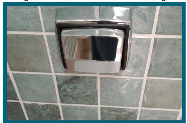
Figura 97 Conserto da válvula da descarga
