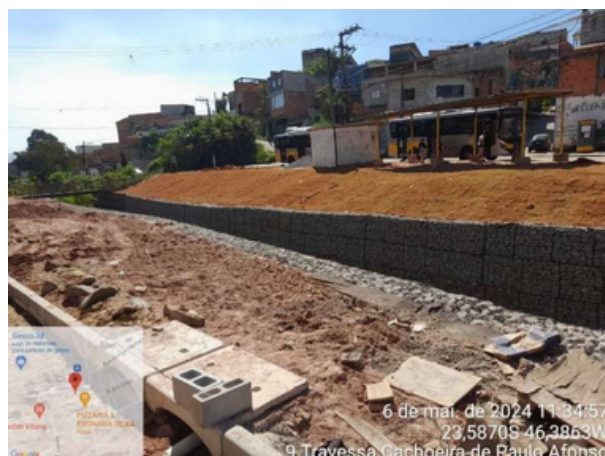
Figura 6 - Drenagem Córrego do Jardim Vitória (SUB-CT)
